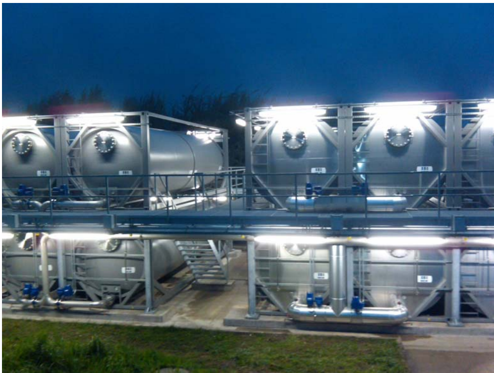
Ansicht Enteisungsanlage
